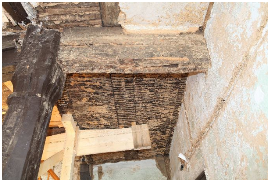
Abb. 4/1: Raum 1.1, Untersicht der Decke zum OG mit Blick auf das Sattelholz unter dem UZ mit Zapfenloch für ein ehem. Kopfband zur Säule, gegen SO; Foto IBD, Juni 2019
