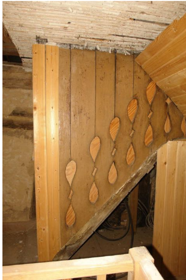
Abb. 7/2: Rezente Treppe vom OG zum DG mit Ansicht der (bauzeitlichen) Ver- bretterung über der SO- Treppenwange, Blick gegen NW; Foto IBD, Sept. 2015
