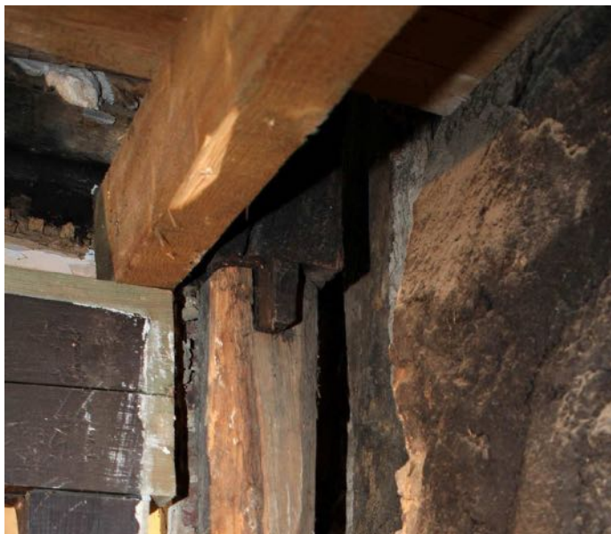
Abb. 19/2: Vorderhaus, EG, Raum 1.1, Mittelstiel der NO-Giebelwand, Zapfen an dem oberen Stiel der Phase 1, da- runter ist der ursprüng- liche Geschossriegel oder Binderbalken der Rückgiebelwand (Ge- binde V5) zu rekonstru- ieren, Blick nach N; Foto IBD, Juni 2019
