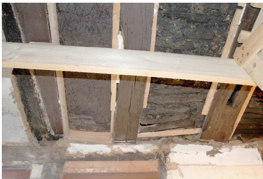
Abb. 9/2: Raum 1.1, Untersicht der Decke mit dem De- cken-/ Binderbalken im Gebinde V4 (Phase 1; im Bild rechts), NW- Auflager mit Zapfenloch in der Unterseite, Blick gegen NW; Foto IBD, Juni 2019
