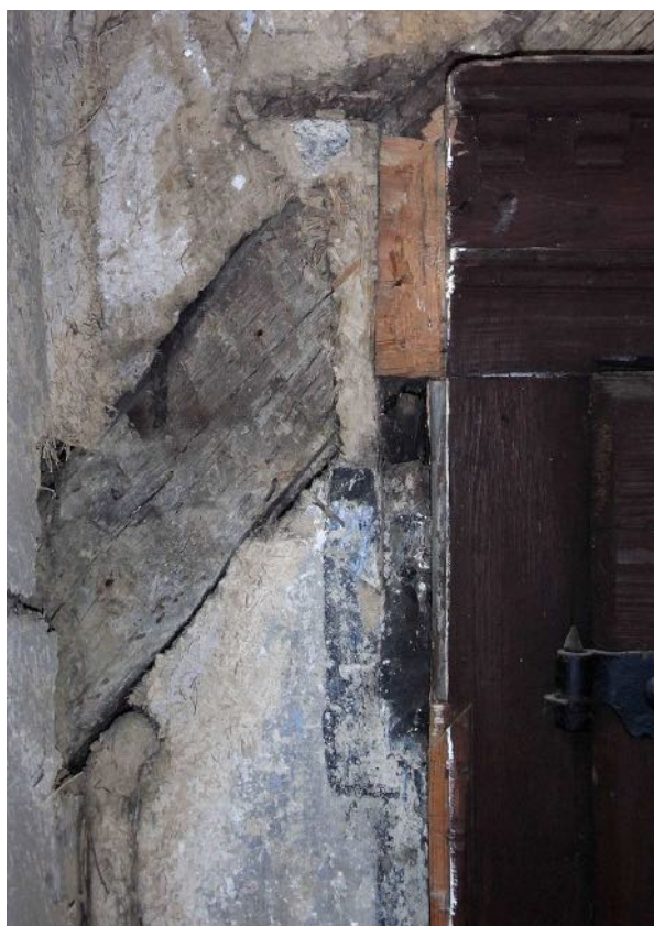
Abb. 22/3: Hinterhaus, OG, Raum 2.7, Tür zum Vorderhaus mit farbig abgesetzter Bekleidung, Ausschnitt SO-Seite, Blick nach SW; Foto IBD, Sept. 2019
