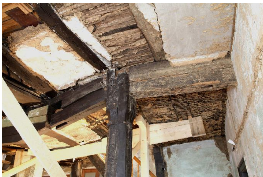
Abb. 5: Raum 1.1, Untersicht der Decke mit Blick auf den 3. Deckenbalken von SW (rechts von der Säule), Blick gegen SO; Foto IBD, Juni 2019
