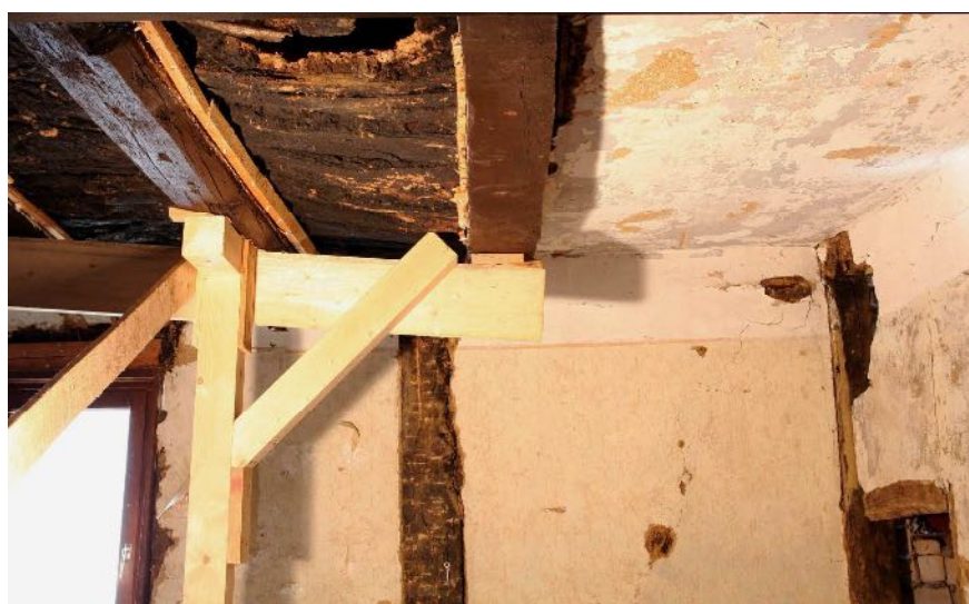
Abb. 10/2: Raum 1.1, Untersicht der Decke mit Blick unter den nordöstlichen Deckenbalken (in der Bildmitte), Zustand nach der Freilegung Blick gegen NW; Foto IBD, Juni 2019
