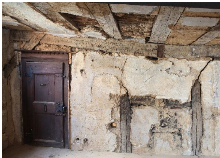
Abb. 13/3 u, 13/4: Raum 2.7, Ansicht der SW-Wand mit dem Bin- derbalken der Usprungskonstruktion der Phase 1, mit nur einem aufgeblatteten Kopfband pro Seite als Queraussteifung, Blick gegen SW; Fotos IBD, Juni 2019
