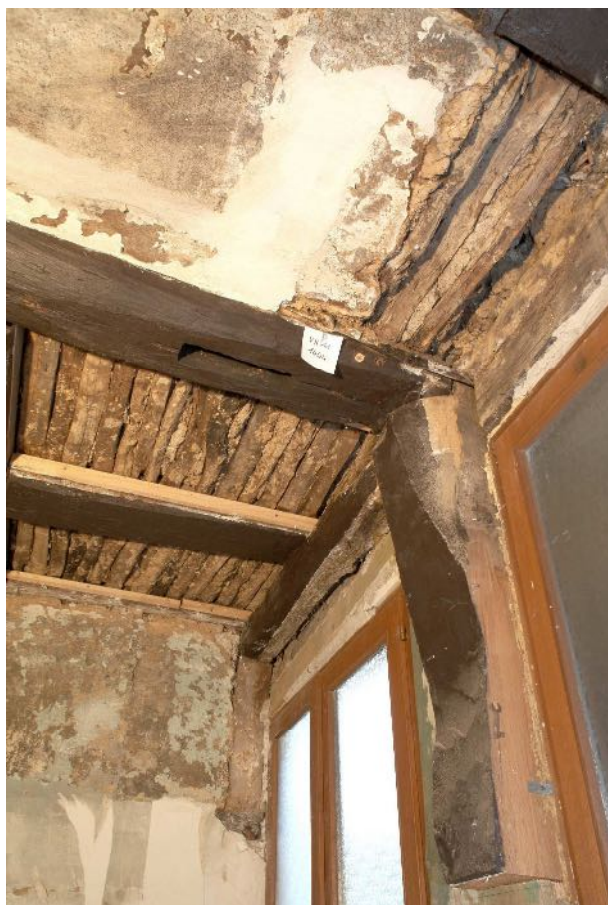
Abb. 9/1: Raum 1.1, Untersicht der Decke mit Blick auf den Decken-/ Binder- balken im Gebinde V4 (Phase 1), SO-Auflager mit Zapfenloch in der Unterseite, aufgelegt auf einen Versatz des sekundären Ständers (des 18. Jhs.), Blick gegen Osten; Foto IBD, Juni 2019
