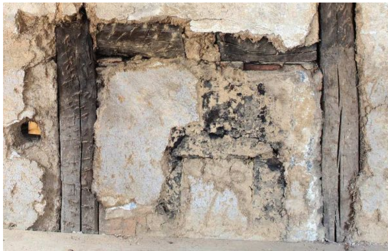
Abb. 21/2: Hinterhaus, OG, Raum 2.7, gemauertes Ofenloch mit Werkstein- rahmen in der SW- Wand (Ausschnitt), Blick nach SW; Foto IBD, Juni 2019
