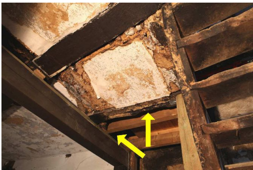
Abb. 12: Raum 1.1, Untersicht der Decke im Bereich einer vermuteten Rauchschrze der ehemaligen Hallendecke vor der NO-Wand des Vorderhauses, Blick gegen NNO; Foto IBD, Juni 2019
