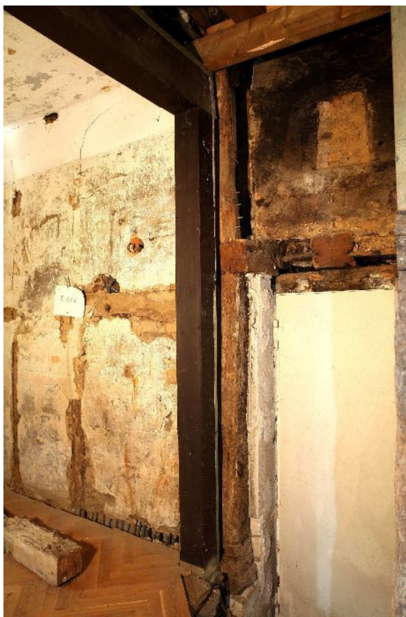
Abb. 19/1: Vorderhaus, EG, Raum 1.1, Mittelstiel der NO-Giebelwand, sekundäres Bauholz im unteren Teil, Blick nach N; Foto IBD, Juni 2019
