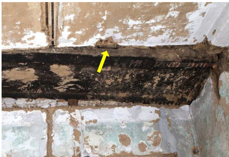
Abb. 1/2: Raum 1.4, Untersicht der Decke mit dem De- cken-/ Binderbalken im Gebinde V2, darin seit- lich das Zapfenloch für einen ehemaligen Stichbalken zur Stra- ßenfassade (Pfeil); Blick gegen NO; Foto IBD, Juni 2019
